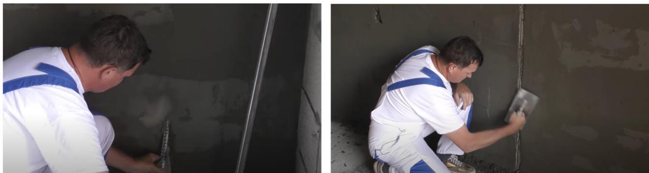
Рис. 27. Схема демонтажа маяков и заделки образовавшихся борозд
